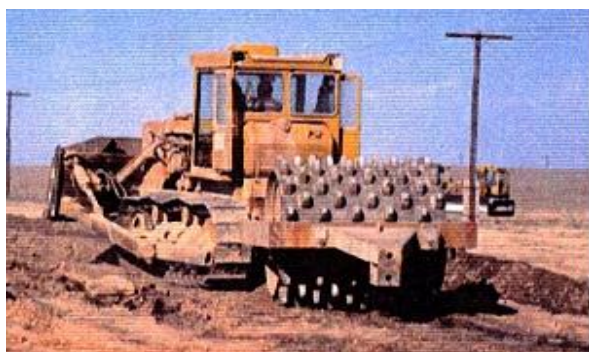
4 сурет - Жұдырықшалы катокпен асфальтбетон жабынын бұзып алу
