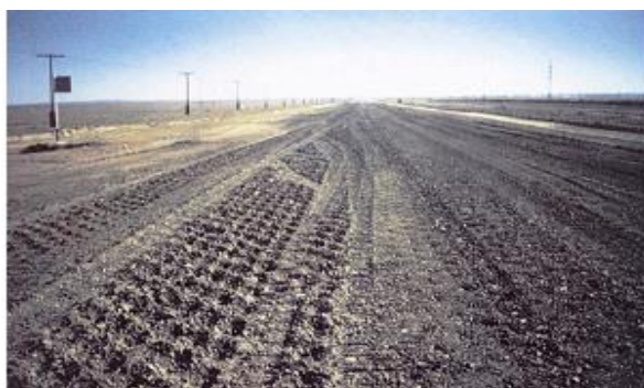
5 сурет - Жұдырықшалы катокпен ұсақталған асфальт сынықтарының жалпы көрінісі
