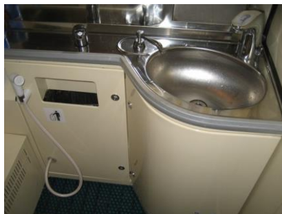
Рис. 2 – Туалетная комната в ТКС Fig. 2 – Toilet room in «TKS»
