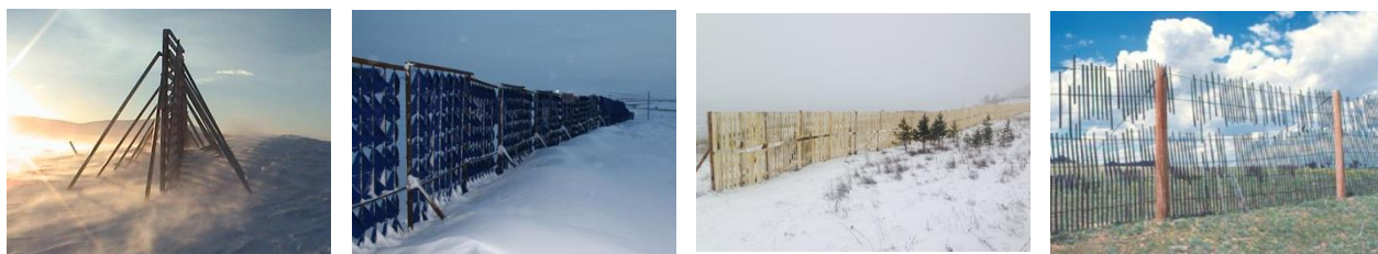
Рис. 1 – Деревянный снегозадерживающий забор Fig. 1 – Wooden snow-retaining fence
