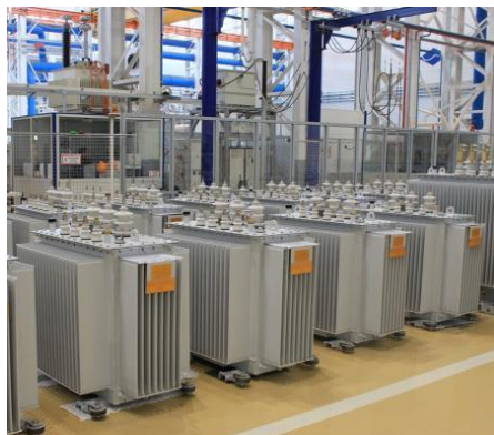
3 сурет – АТДЦТН-125 трансформаторы
