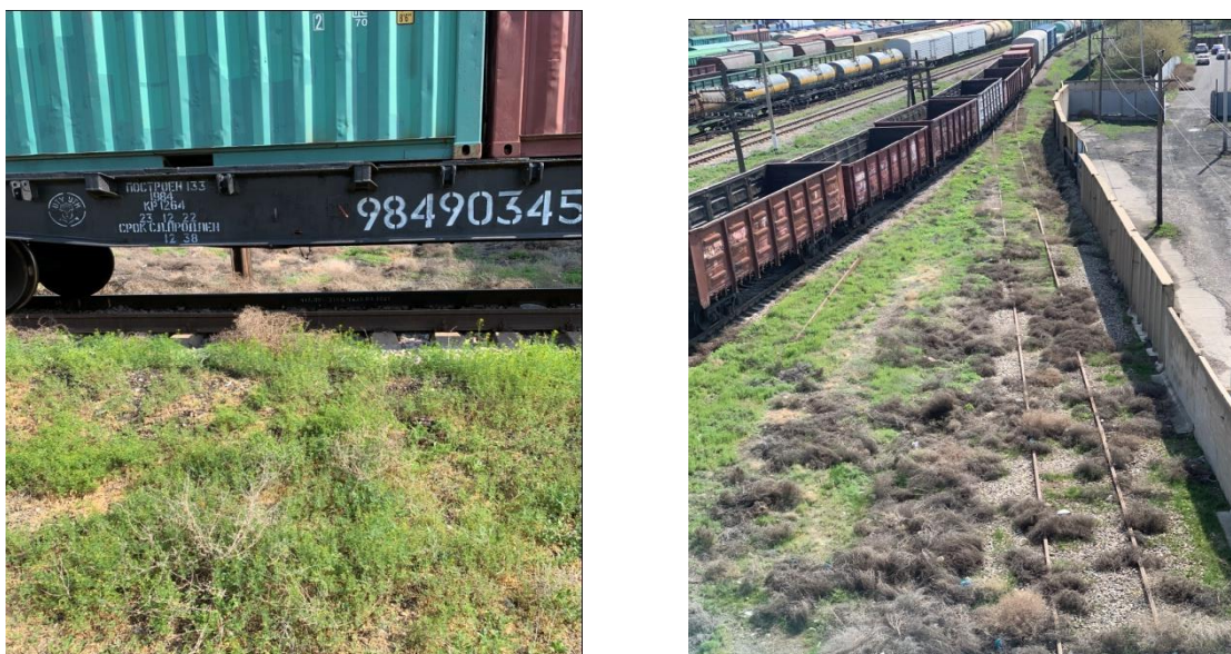
Рисунок 1 – Фотофиксация распространения сорной растительности на железнодорожных путях
