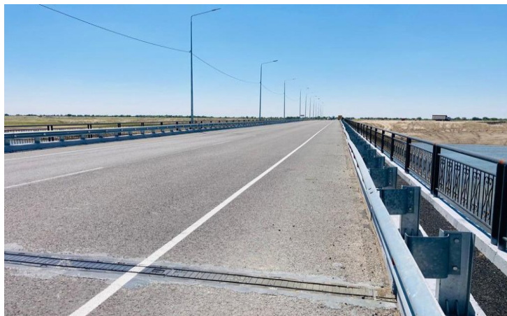
Рисунок 6 – Проезжая часть автодорожного моста через реку Шу
