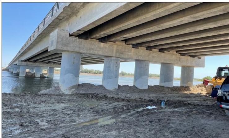
Рисунок 3 – Общий вид промежуточной опоры №2
