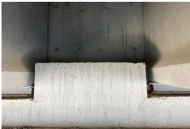
Рисунок 5 – Антисейсмический упор для предотвращения поперечных смещений балок
