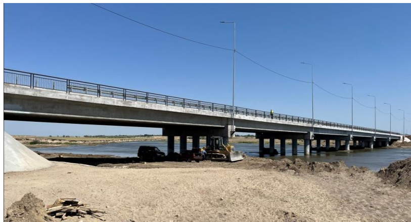
Рисунок 1 - Общий вид автодорожного моста через реку Шу
