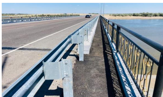
Рисунок 11 – Асфальтобетонное покрытие на служебном тротуаре
