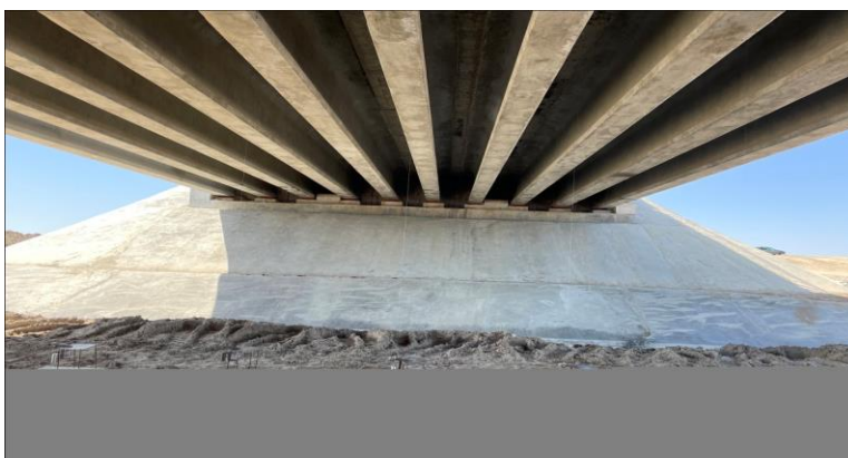
Рисунок 2 – Балки ВТК-33у, опирающиеся на крайнюю опору №1
