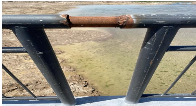
Рисунок 12 – Деформационная вставка в перильном ограждении на опоре №2
